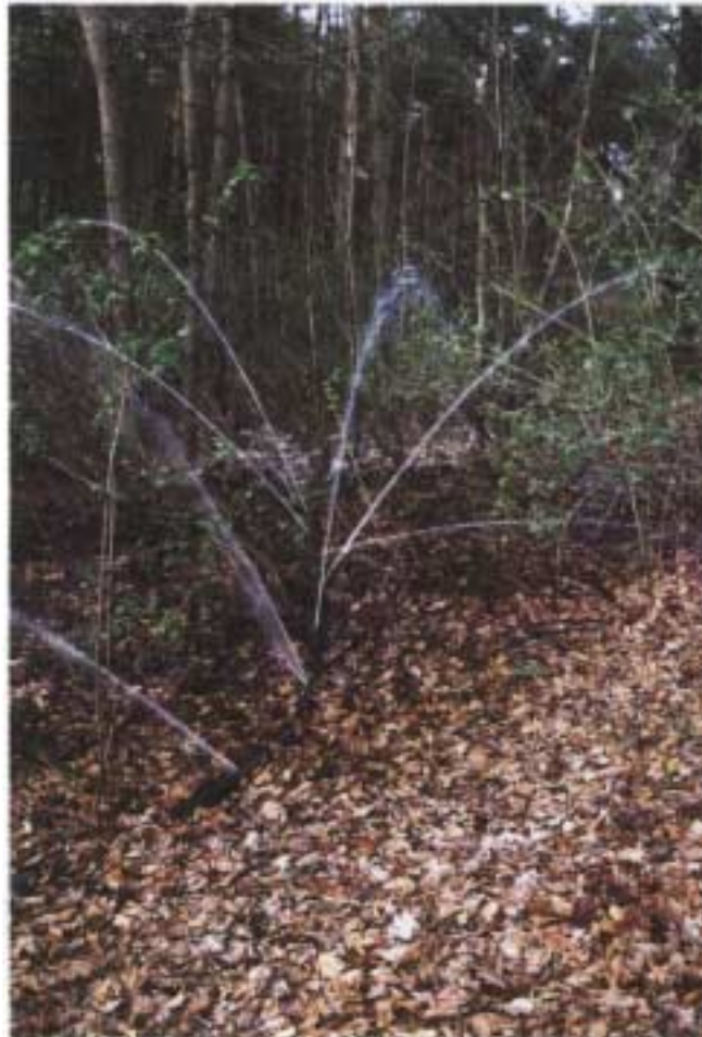
Abbildung 5., Flächige Verrieselung von abgepumptem Grundwasser im Bereich eines Kiefernforstes. (Foto.- H. Platte, 1997).
