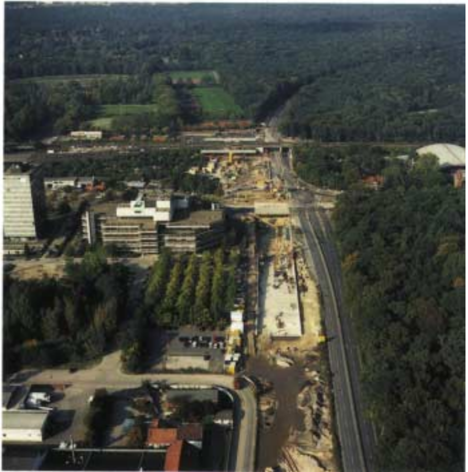
Abbildung 1: Pferdeturm-kreuzung während Absenkungsphase 2, Eisenbahnunterführung in oberer Bildhälfte (Luftbild v. 7.10.1996, Karl Joseph).
